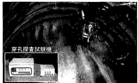
写真-1 前方探査実施状況
