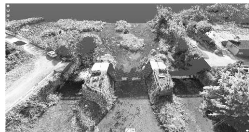
図-2 橋梁部分除去後
