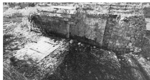
図-3 樋管周辺の状況(橋梁除去後)
