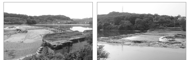
左:左岸側より(手前は舟通し閘門)・右:右岸側より(手前は導水堤と導水路)
