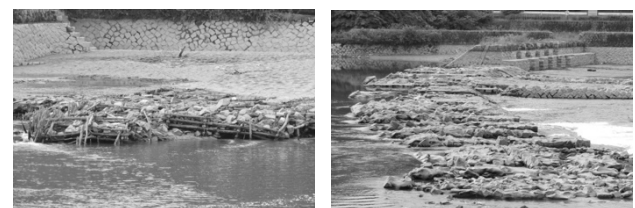
左:旧頭首工下流の木工沈床・右:撤去された中央～右岸のゲートピアの基礎
