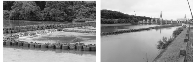
左:旧頭首工への大型土囊積み・右:嵩上げされた旧導水堤 図-6 応急措置に活用される遺構(2022年7月)
