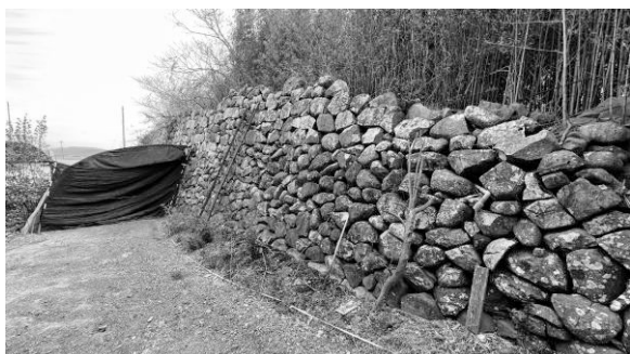
写真-4 河川堤 (民地に接する部分)
