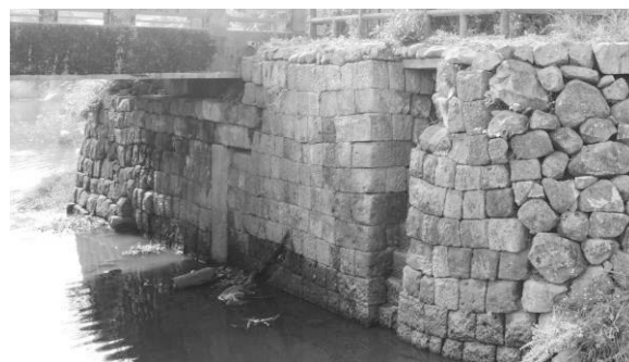
写真-5 島津樋門跡左岸側石垣
