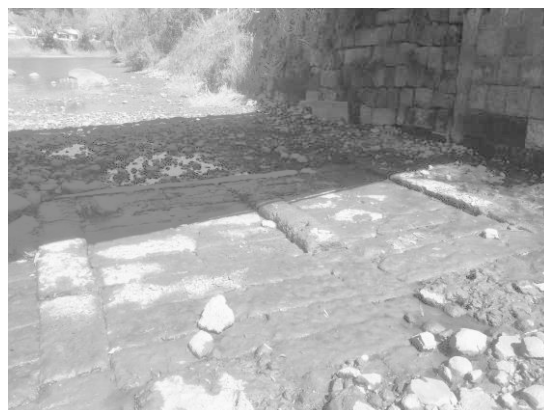
写真-6 樋管の敷石
