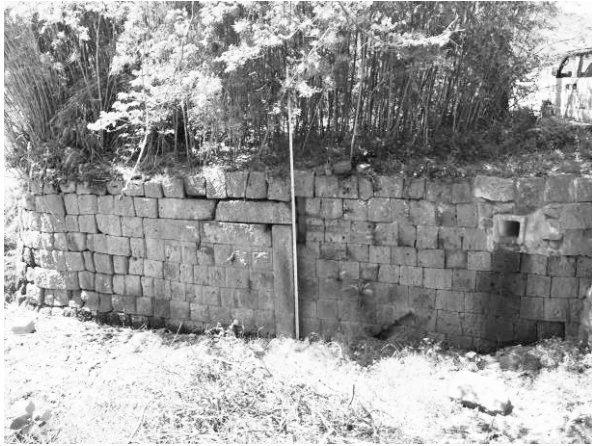
写真-7 瀉樋門左岸側
