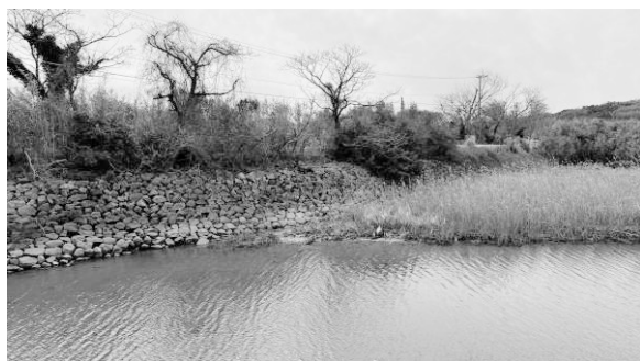
写真-3 河川堤 (江内川護岸)
