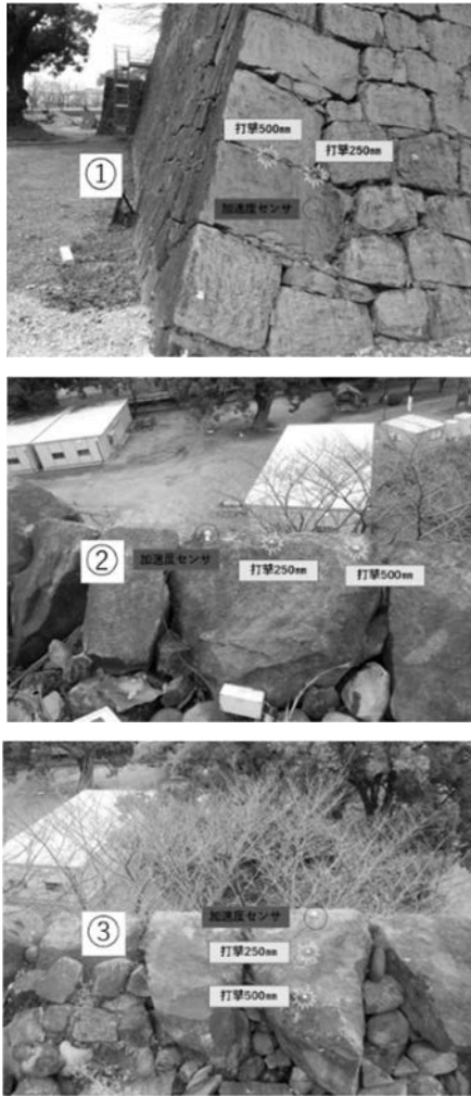
図-8 築石上の打撃位置例（地点①～③）
