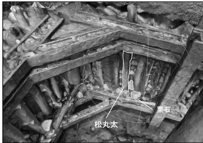
図-11 第二杵の立成木とそれを支える鋼製杵 (池の内壁画像より)
