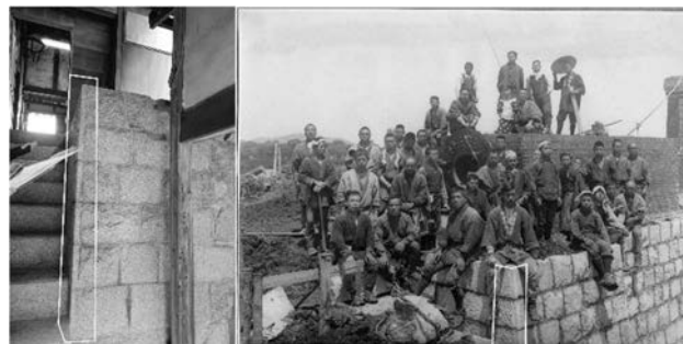
写真-1 ポンプ小屋裏の石垣の(左)現在(2022年7月5日筆者撮影)と(右)建設当時の古写真(明治43年5月15日撮影)(『石畑区有文書』「工事従業員」、筆者加筆)
