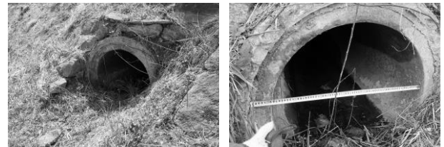
図-14 左：沈殿池内より撮影、右：コンクリート製管 安積疏水からの流入口の東側に、内径 680 mm、外径 830 mm、外周コンクリート厚 60mm の遺構が確認される。豊田貯水池の水源としていた安積疏水第五分水路が、周辺の宅地開発による生活污水の流入や農地からの農薬流入の可能性が指摘され、新たな水源の必要性が高まったことを受け、昭和 37~39 年実施の第 3 次拡張工事において、安積疏水第五分水路の上流の矢地内に取水場を建設し、それを新たな水源として豊田貯水池に導水された。導水管は口径 600~800mm のアスファルトジュート巻鋼管とされており、概ねコンクリート製管と合致する。現場の状況から矢地内取水場から豊田貯水池の着水井までがアスファルトジュート巻鋼管で、着水井から取水する管はコンクリート製管であったことが想定され、現場の
