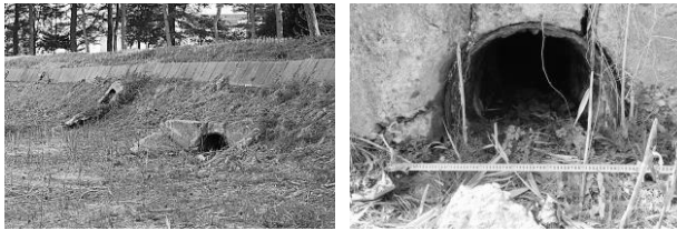
図-15 左：沈殿池内より撮影、右：鉄管
