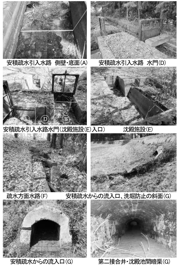
図-12 安積疏水引入関係の一連の施設
