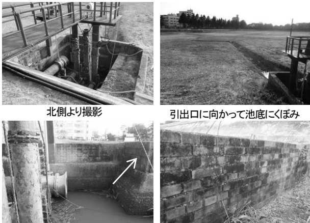
泥水混入防止側壁(矢印はコンクリートブロック改修) 側壁煉瓦積部分
