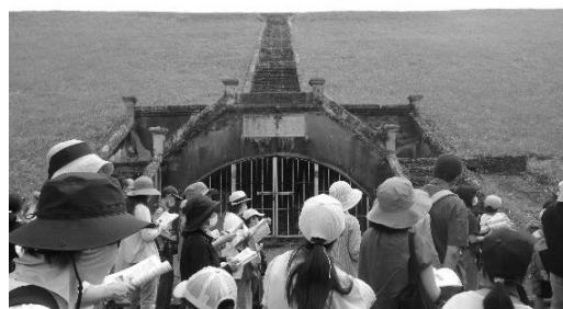
写真-7 普段は立ち入れない本河内浄水場内
