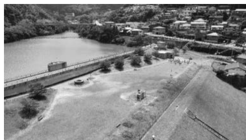
写真-8 旧堤体の階段で本河内高部ダム天端まで移動
