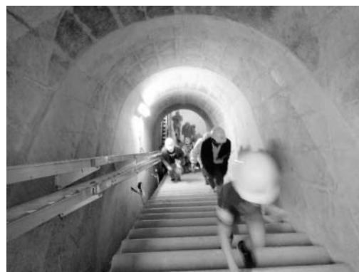
写真-9 本河内高部ダム監査廊内
