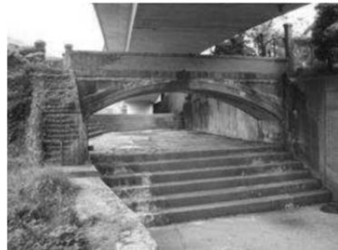
写真-3 放水路橋（日本初の鉄筋コンクリート橋）
