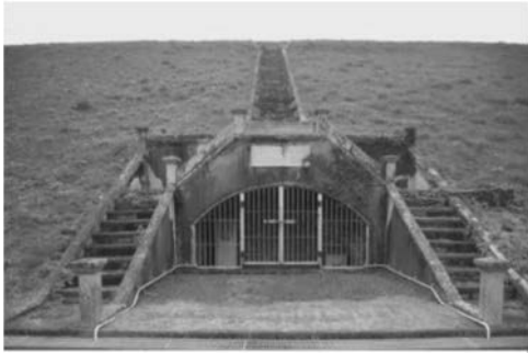
写真-1 本河内高部ダム正面（導水隧道跡）
