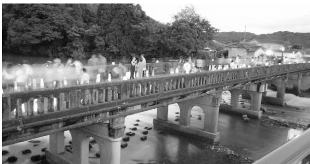
図-6 井戸端会議の場となった山田橋の橋上空間
