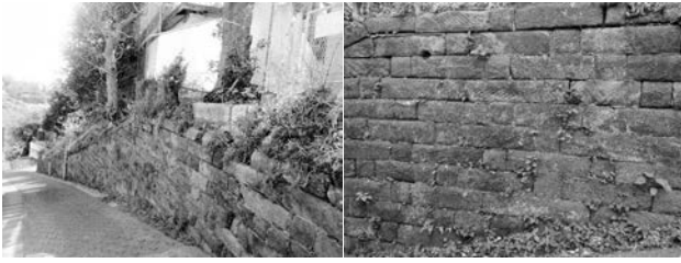
写真-1 ブラフ積擁壁の一例
