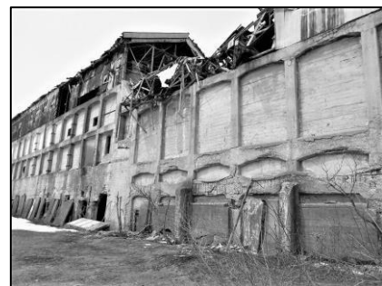
写真-2 積雪により崩壊した旧奔別炭鉱選炭機ホッパー屋根
