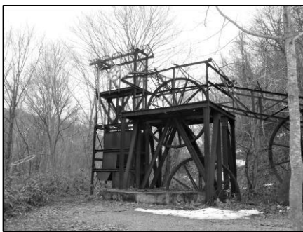
写真3 道内現存最古の旧北炭幾春別炭鉱の錦立坑櫓
