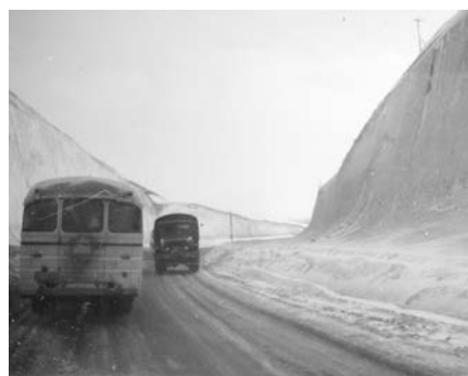
図-2 弾丸道路の火山灰の直立法面
