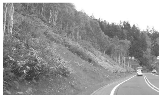
図-7 緩傾斜の法面と遷移してきた植生
