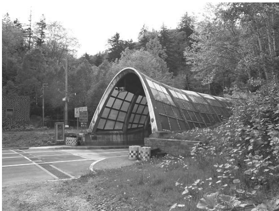
図-6 定山溪トンネルのルーバー
