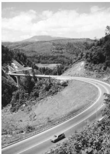
図-3 弾丸道路の火山灰の直立法面
