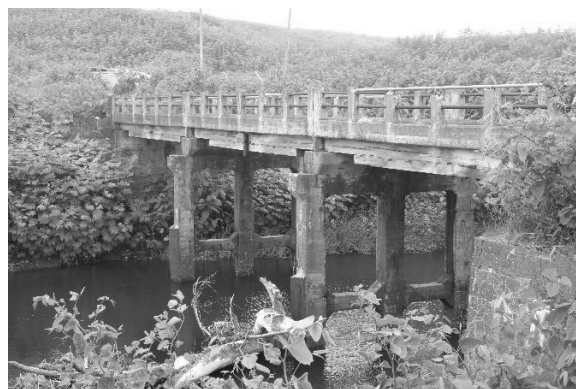
写真-1 北海道に現存する木コンクリート橋（歌越別橋）
