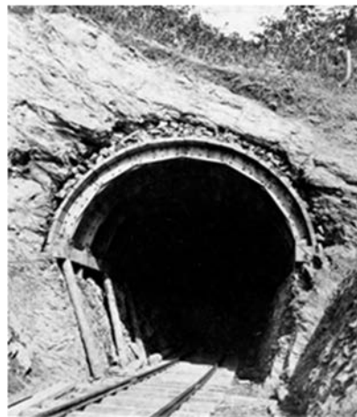
写真-1 神居古潭第2隧道 4)
