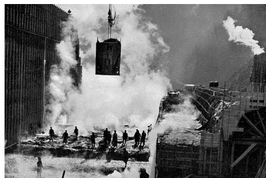
写真6 寒中コンクリート打設
