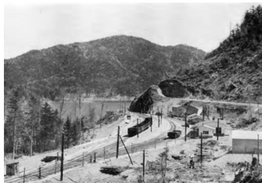
写真4 付替後の土幌線と糠平駅（工事記録より）
