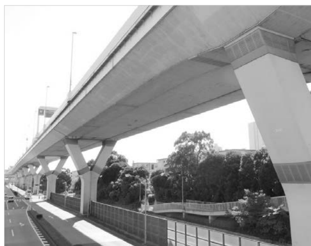
図-6 辰巳高架橋 外観 [8]
