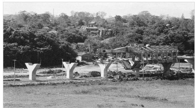
図-8 高島平高架橋 SSM 式移動吊支保工 [10]
