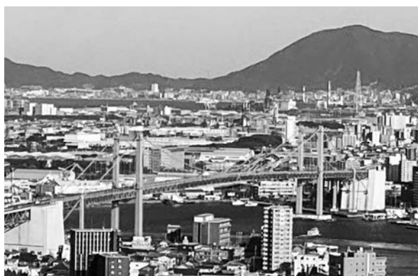
写真-1 若戸大橋現況（2023（令和5）年2月26日撮影） 注3)
