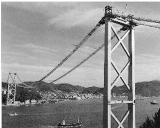
写真-2 ストランド架設設備全景 (1971年9月) 13)
