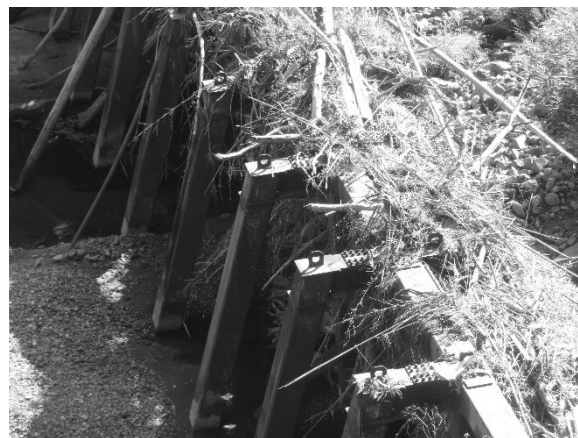
写真-12 中原川砂防ダムの現況写真 （撮影日：2021年11月20日）
