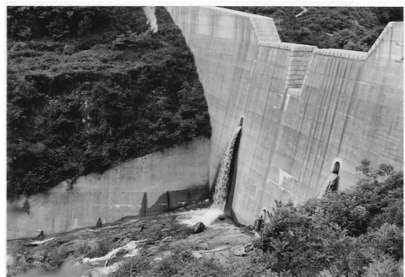
写真5 竣工後の杉谷堰堤 （国交省六甲砂防事務所より）
