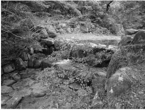
写真-13 紅葉谷川庭園砂防施設(第一号堰堤)現況写真 (撮影日：2019年2月22日)
