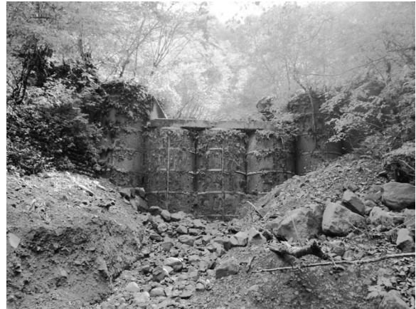
写真4 餌掛谷第3号砂防堰堤 現況写真 （撮影日：2020年10月17日）
