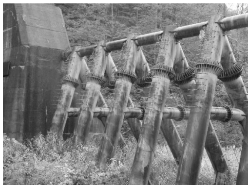
写真9 白田切川第5号スリットダム (鋼製スリットダムA型・上流側) (撮影日：2021年10月23日)
