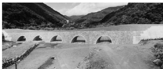
写真-10 地獄平砂防堰堤（神坂上流砂防堰堤） 完成時写真（神通川水系砂防事務所）
