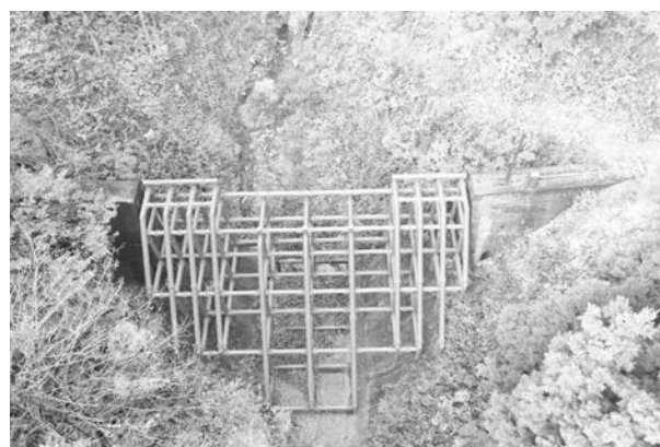
写真-8 小六郎沢砂防ダム（鋼製格子型） 現況写真（ドローン画像） （撮影日：2020 年 10 月 31 日）
