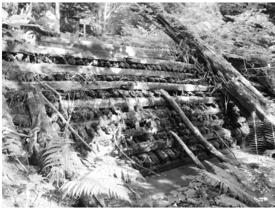
写真3 坪毛沢4号木製堰堤（撮影日：2020年8月26日）
