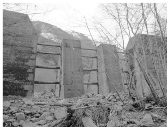
写真-6 蓬沢砂防堰堤 現況写真（下流側） （撮影日：2020 年 12 月 22 日）
