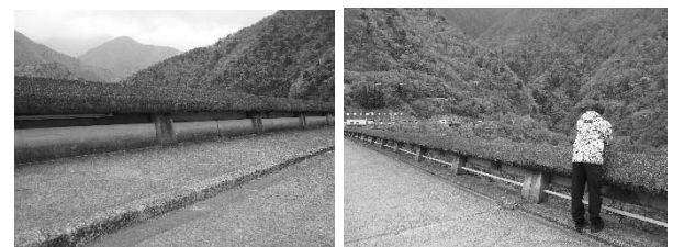
図-3 天端高欄：出典6) (左/上流側 右/下流側)
