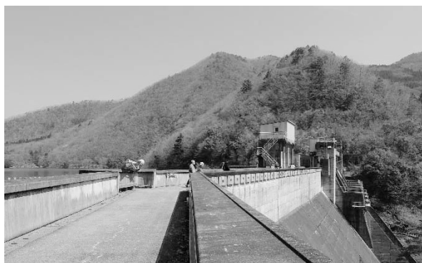
図-6 大野ダム：屈曲部に組込まれたバルコニー。堤頂部にはデンテル意匠もみられる
