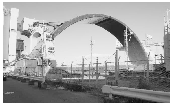
図-9 安治川水門：出典6) バイザーゲート式アーチ水門
