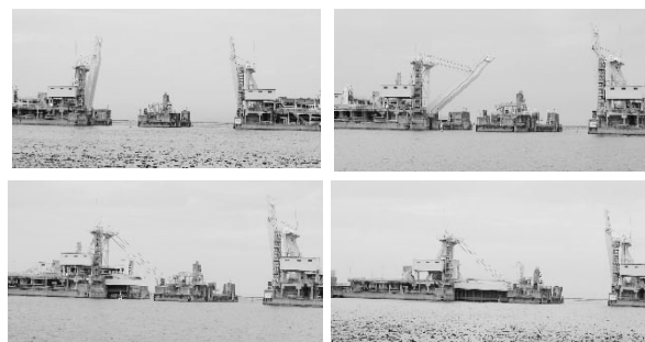
図-8 岸和田水門：出典6) 定期点検運転時の開閉状況
