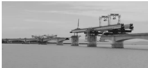
写真—37 キャンチレバー, 架設桁による架設状況
