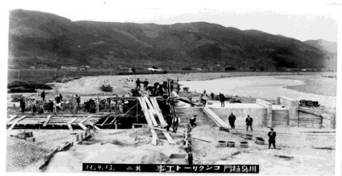
写真—10 川島堤防と川島樋門工事 大正12年
