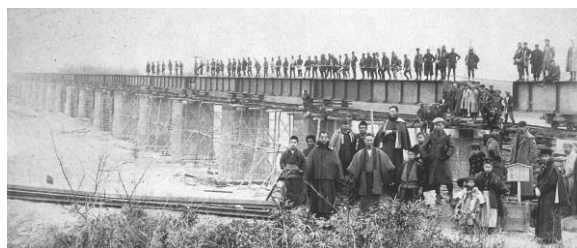
写真—21 鮎喰川鉄橋（明治31年）「目で見る徳島100年」
