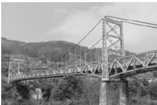
写真—23 三好橋（日本橋梁（株）提供）
