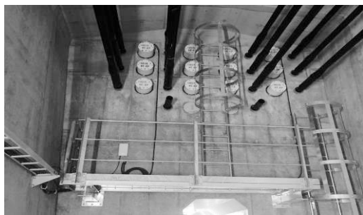
写真—34 外ケーブルと端末状況 (柱頭付近)
