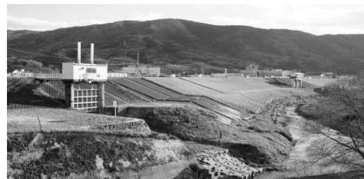
写真—11 現在の川島樋門
