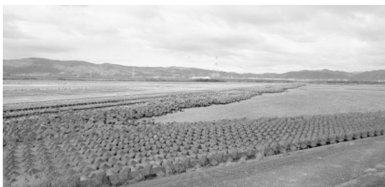
写真—14 現在の第十堰
