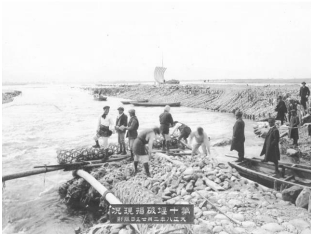
写真—12 第十堰破損復旧工事 背後に舟運の平田船 (大正8年2月 徳島県姫野組提供)
