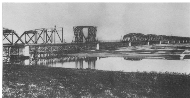
写真—31 吉野川橋架設支保工、クレーン架設 (徳島県吉野川橋工事概要)
