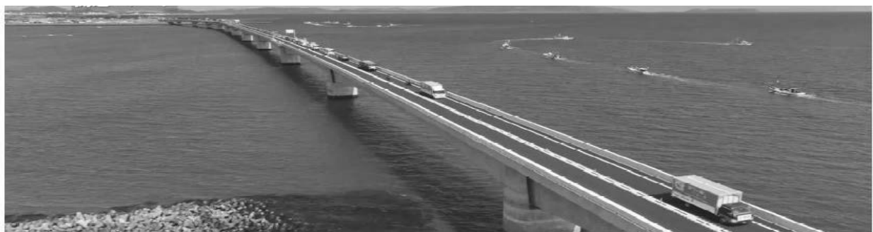
写真—38 吉野川サンライズ大橋開通式パレード状況 (NEXCO 西日本)
