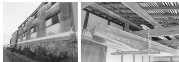
写真-2 左 藍商蔵 高石垣 右 避難用吊り船
