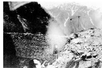
大正11年5月27日復旧工事中の白岩堰堤左岸部 10)
