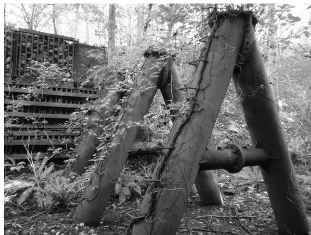
写真8 小有珠右の川1号スリットダムの現況写真 （撮影日：2020（令和2）年9月19日）
