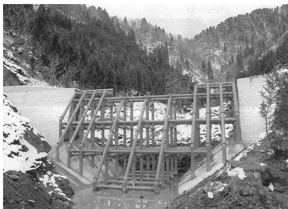
写真9 小六郎沢砂防堰堤（鋼製格子型）・完成時写真 18)
