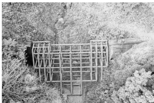
写真10 小六郎沢砂防ダム（鋼製格子型）現況写真 （ドローン画像、撮影日：2020（令和2）年10月31日）
