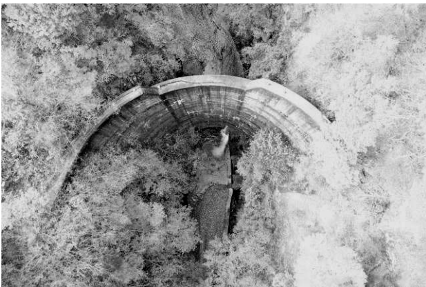
写真-2 真船堰堤の現況写真 （ドローンによる撮影、撮影日：2020（令和2）年11月1日）
