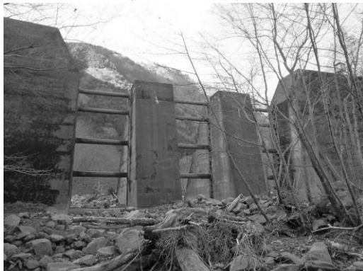
写真-12 蓬沢砂防堰堤 現況写真(下流側) (撮影日:2020(令和2)年12月22日)
