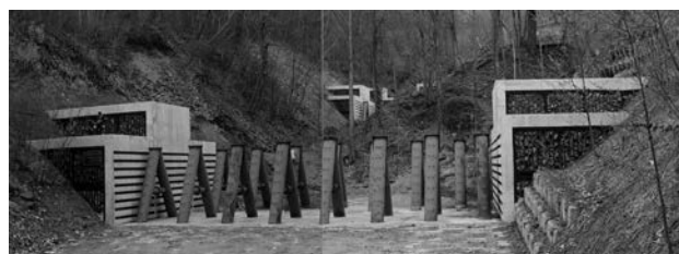
写真7 竣工時の小有珠右の川1号スリットダム 14)
