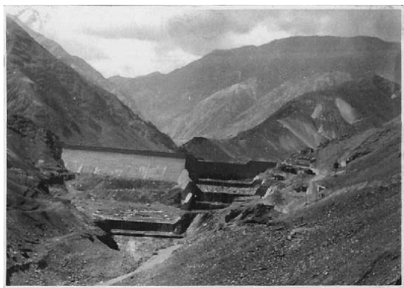
写真3 足尾砂防堰堤 建設当時写真 1)
