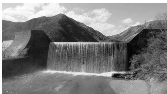
写真4 足尾砂防堰堤 現況写真（越流堤部） （撮影日：2020（令和2）年3月11日）
