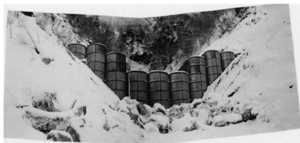
写真5 完成直後の餌掛谷第3号砂防堰堤 2)
