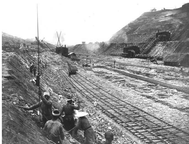
図2 100年以上前的大河津分水の掘削工事
