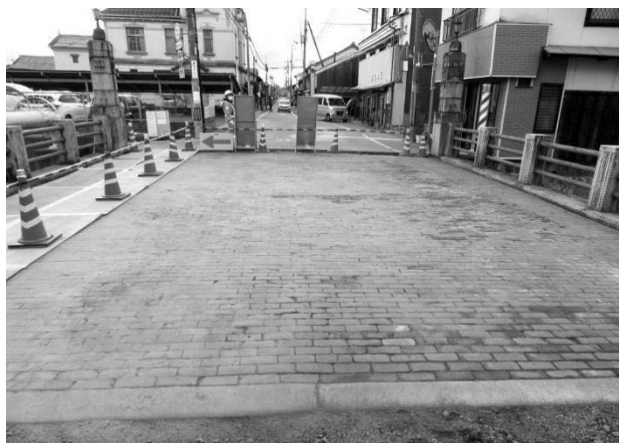
写真-1 翁橋の煉瓦舗装 (2021.12.7 樋口輝久撮影)
