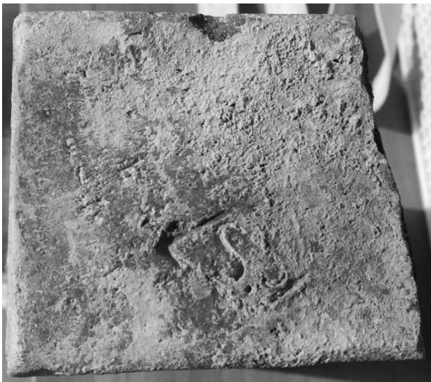
写真-2 「S.S」が確認できる翁橋の煉瓦（津山市提供）
