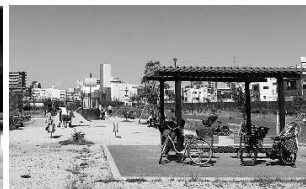
図4 トンネル地上部の公園化(正蓮寺川)
