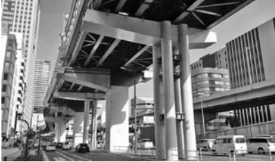
図10 鋼製集成橋脚(西船場 JCT：大阪市西区・中央区)
