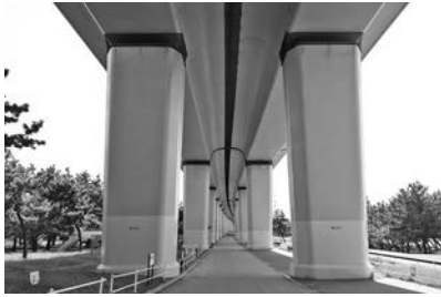
図9 八角断面橋脚(二色の浜：貝塚市)
