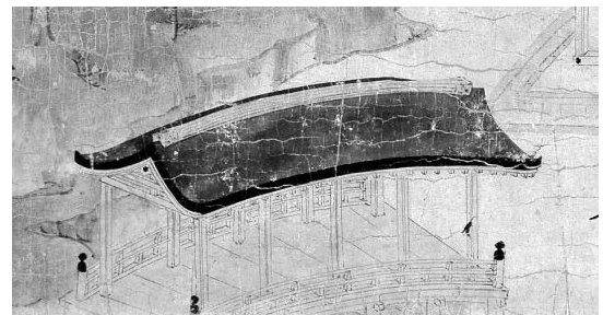
図-22 『天狗草紙』(延暦寺巻)日吉社西本宮横亭橋
