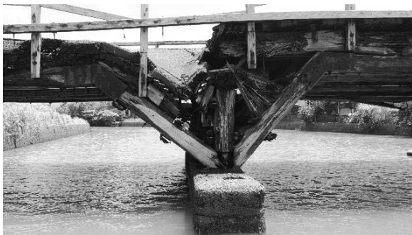
写真-2 上流・左岸側の橋脚付近
