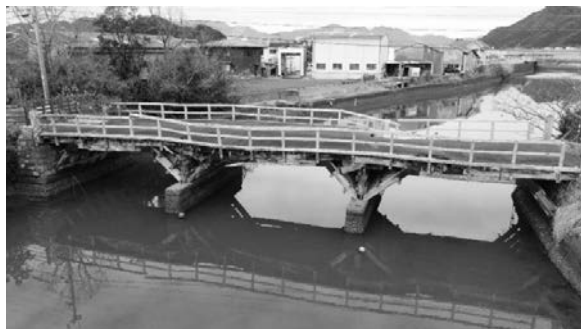
写真-1 花峯橋全景(下流側)
