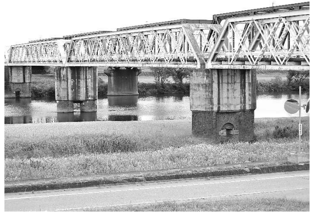
図-9 旧揖斐川橋梁の下部工 (塗替工事前に筆者撮影)
