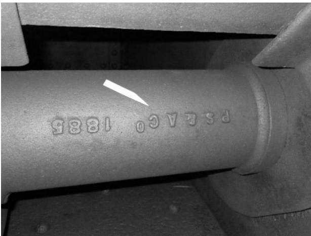
図-7 旧揖斐川橋梁のピン靴管の刻印（筆者撮影）
