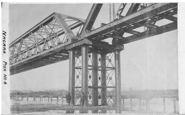
図-3 長良川橋梁の橋脚を詳細に示す写真 (表-2の③)
