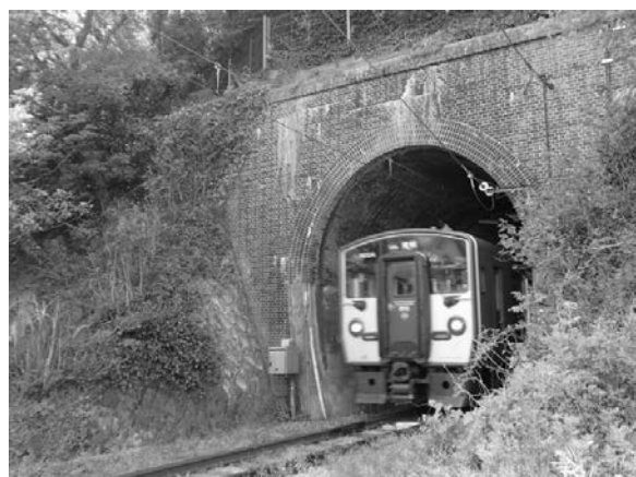
写真5 第6工区第一津組トンネルの東側 佐伯線の各トンネルの坑口は石積みアーチではなく、煉瓦積みとなっている。(2018年4月筆者撮影)
