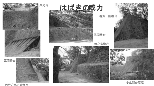
図-2 熊本城城郭におけるはばきなど補強
