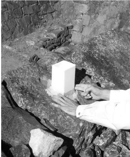
写真-4 傾斜センサ設置時の様子
