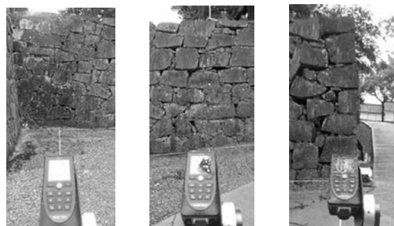
(a) 13m地点 (b) 10m地点 (c) 0m地点 写真-1 東竹之丸西面石垣での計測の様子
