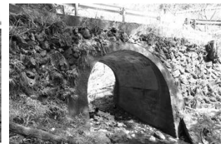
図-7 旧式の横断工作物の例 土堤・アーチカルバート(区間3)
