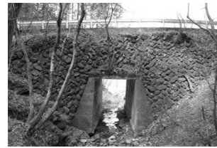
図-6 旧式の横断工作物の例 土堤・ボックスカルバート(区間1)
