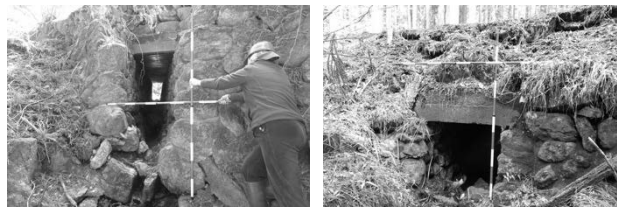
図-5 石積み橋台を有する溝橋の例(区間 2)
