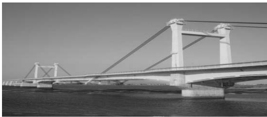
写真-1 4 阿波しらさぎ大橋
