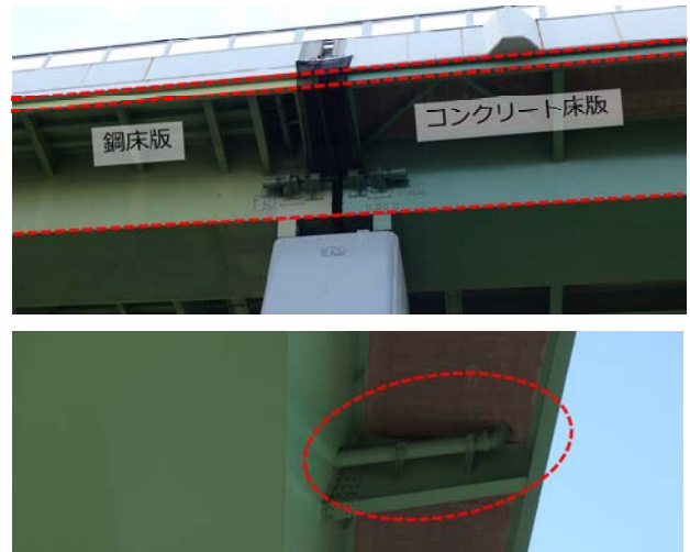
図5 詳細部の設計(若宮大通区間の高速道路)
