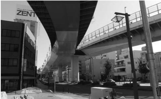
図-8 桁の構造変化部における連続性の確保
