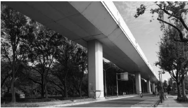
図-7 名古屋城外堀区間の高速道路
