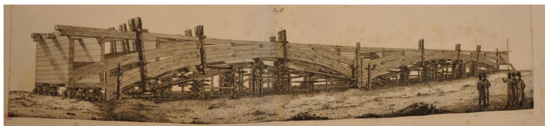
図-12 ヴィーベキングによる木造アーチ橋施工の様子
