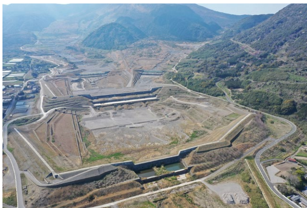
写真-4 評価軸「規範性」の事例 （砂防ソイルセメントを使用した堰堤：水無川1号砂防堰堤）
