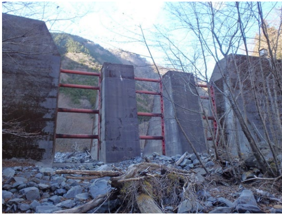
写真6 評価軸「唯一性／希少性」の事例 (コンクリートスリット砂防堰堤・スリット部鋼製ビーム構造：蓬沢砂防堰堤)
