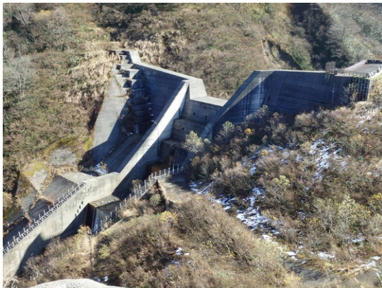
写真7 評価軸「唯一性／希少性」の事例 (重力式コンクリート形式と均一性フィルダムの複合型堰堤：火打山川第1号砂防堰堤)
