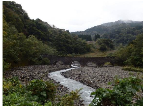
写真9 評価軸「意匠性」の事例 (大暗渠砂防堰堤：浦川スーパー暗渠砂防堰堤)
