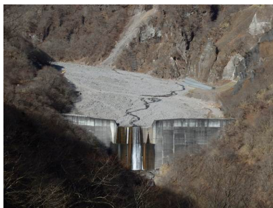
写真-5 評価軸「到達点」の事例 （その時代の代表的な形式の砂防堰堤：日向砂防堰堤）
