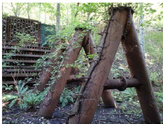
写真-3 評価軸「新規性」の事例 （鋼製スリットA型：小有珠右の川1号スリットダム）
