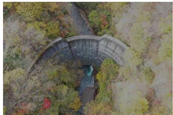
写真-2 ドローンによる施設の撮影 (真船砂防堰堤)
