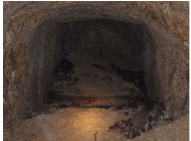
写真-5 素掘りの状態で岩盤がむき出しの地下通路
