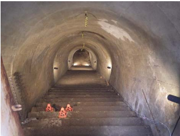
写真-3 旧呉鎮守府庁舎海側から地下通路へと繋がる階段
