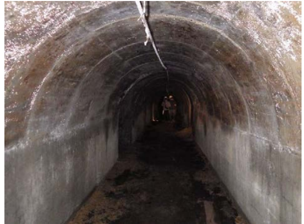
写真-4 コンクリート製の壁面で覆われた地下通路
