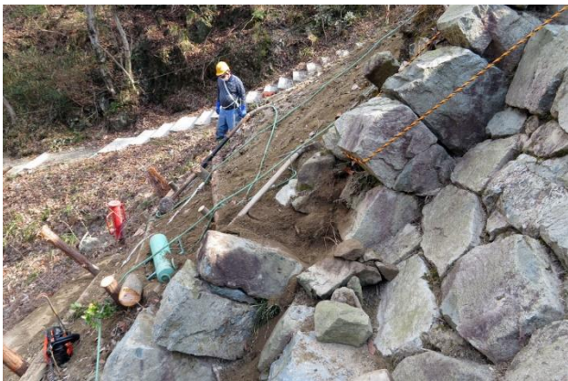
写真-11 修復前の十三番砂留の水通し側壁
