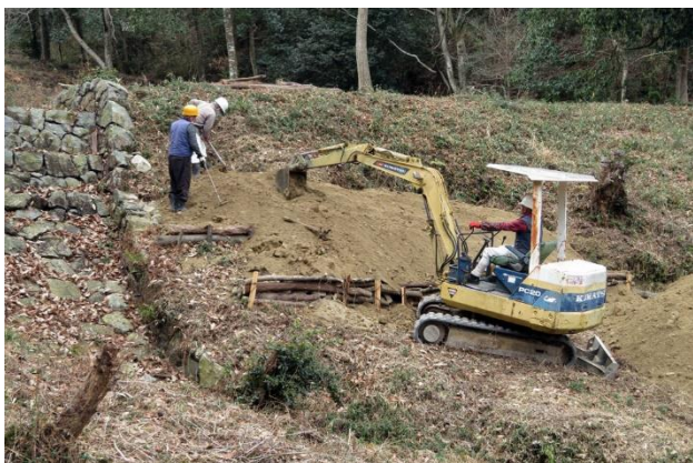
写真-5 五番砂留では油圧ショベルで盛り土をした
