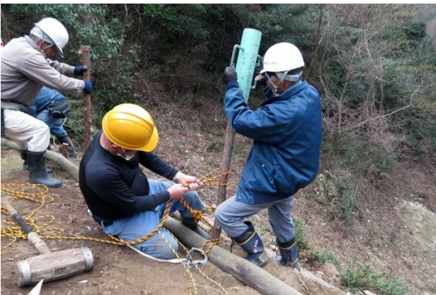
写真-2 支柱ハンマーによる杭打ち
