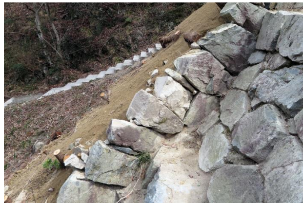
写真-13 修復後の十三番砂留の水通し側壁
