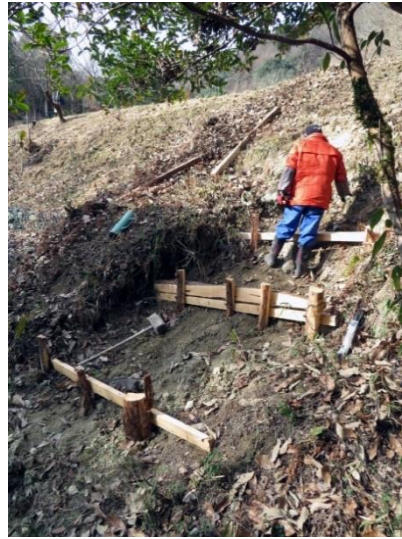
写真-4 二番砂留に設置した土留工
