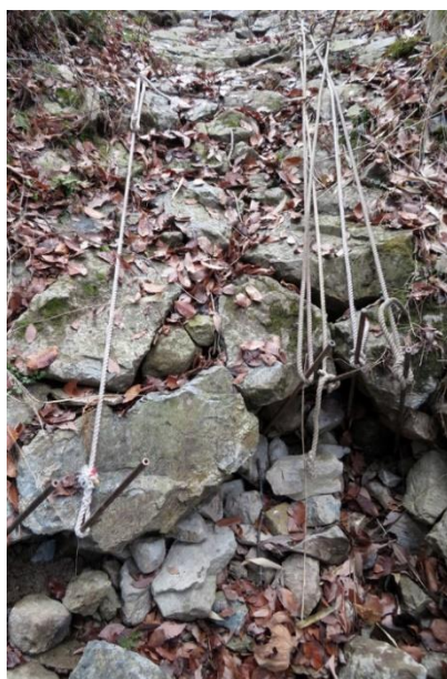
写真-7 石材をロープで牽引する
