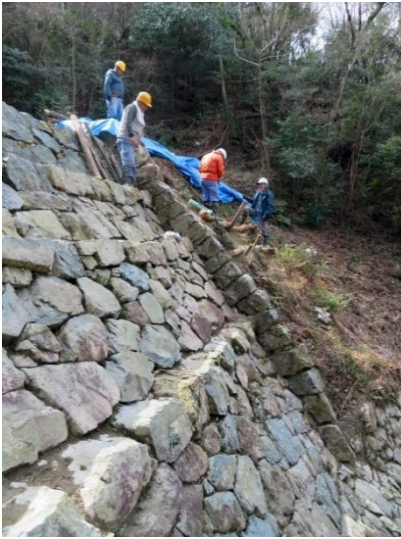
写真-1 十三番砂留の修復現場
