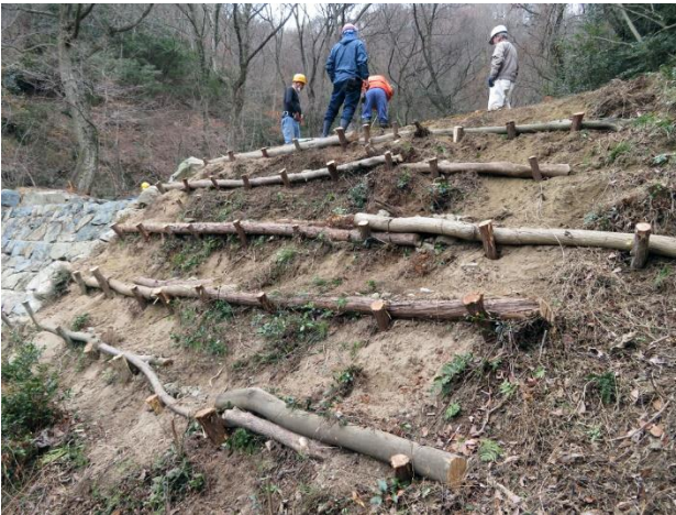
写真-3 十三番砂留の左岸側に設置した土留工
