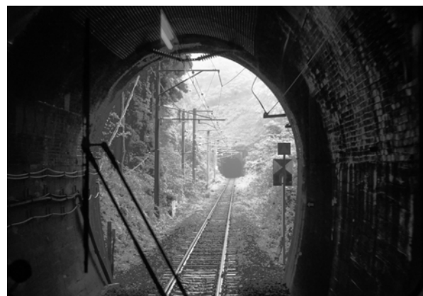
写真-1 第2浪太トンネル内部
