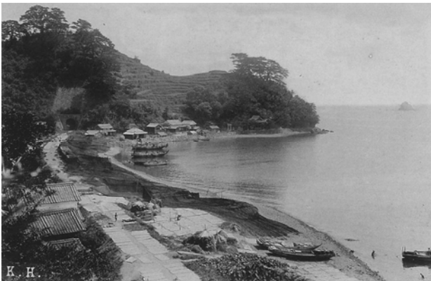
写真2 建設時の古江トンネル西口付近 (漁村のなかで建設工事が進んでいる（『佐伯線建設工事一覧』鉄道院大分建設事務所、1916））
