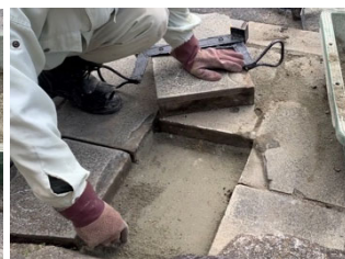
写真4.3 修復工事②
