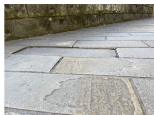
写真 5.7 板石が陥落
