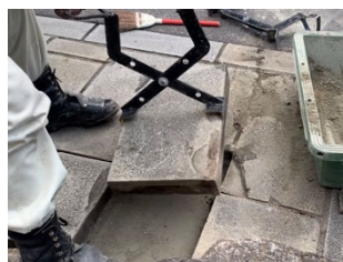
写真4.2 修復工事①
