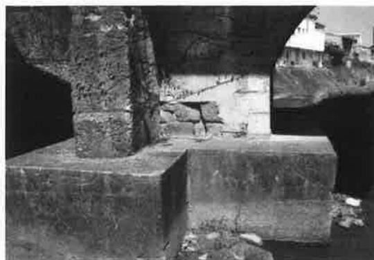
写真-3 現在の橋脚背後の切石積
