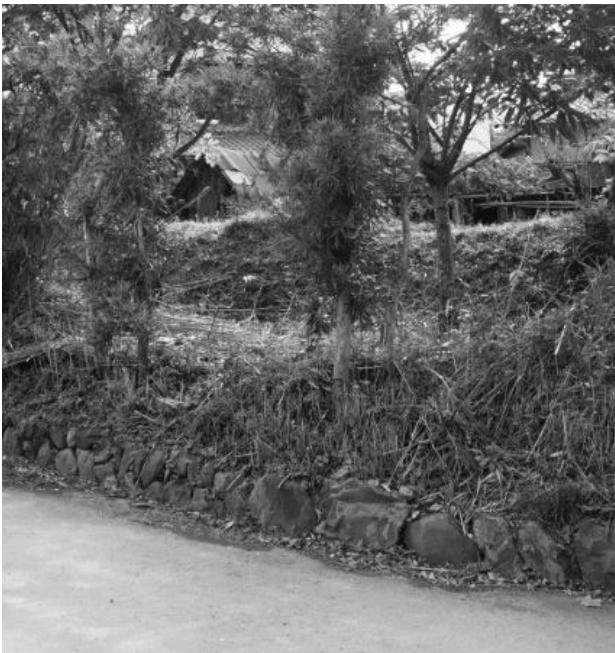
写真-1 回答者33宅内の土堤（道路側から11月21日撮影）
