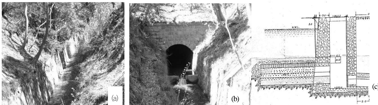
図-4. 烏原貯水池の放水路(a), トンネル(b) および伊屋谷川 (石井川) の分水堰堤とろ過層
