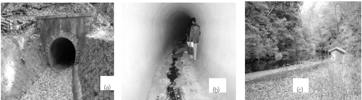
図-11. 武庫離宮水道のバイパストンネル (a)、トンネル内部 (b) および天皇の池 (c)
