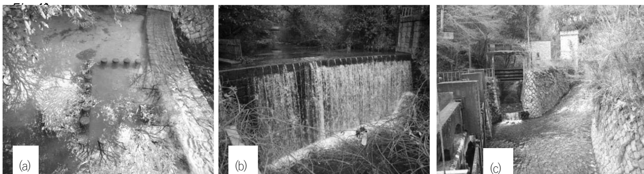
図-3. 烏原貯水池 -一分水堰堤 (a, b) および締切堰堤と合流箇所 (c)
