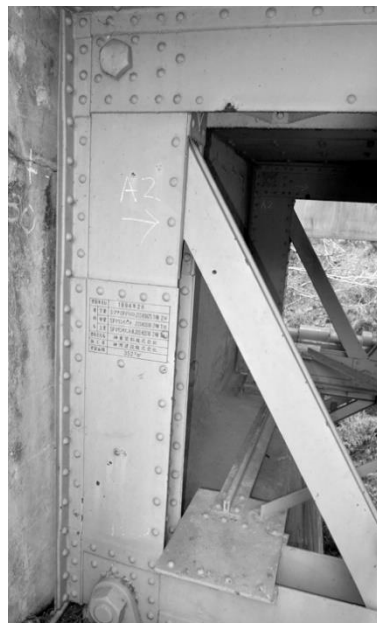
写真 - 10 大宮橋左岸上流側端柱外側
