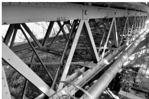
写真 - 1 大宮橋桁全景 - 上流側
