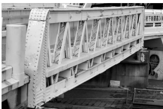
写真 - 3 浜中津橋全景—下流側
