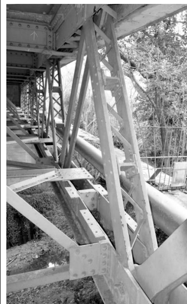
写真 - 11 大宮橋上流側桁詳細
