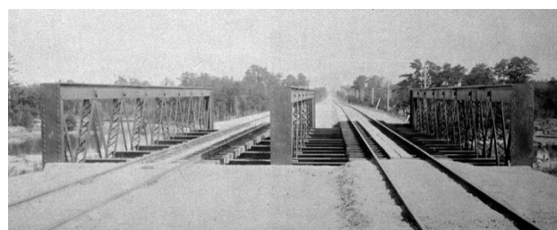
写真 - 2 東海道本線・旧光善寺川橋梁：右側は格点間の横桁が2本、左側は1本になっている。 6)
