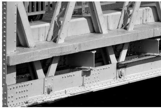
写真 - 7 浜中津橋右岸下流側格点 1～2間の下弦材
