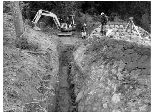
写真-5 七番砂留の水通し上流側トレンチ
