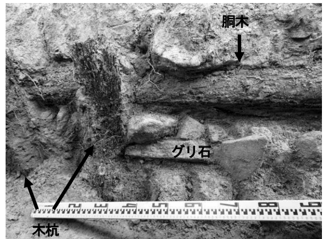
写真-6 グリ石・胴木・木杭が確認できる七番砂留の基礎
