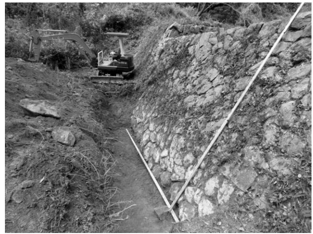
写真-8 八番砂留の水通し上流側トレンチ
