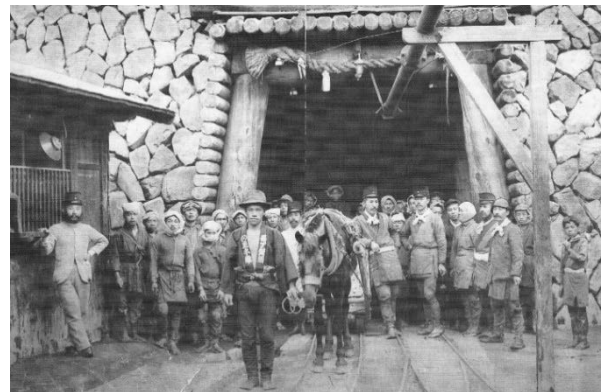
写真-2 本山坑内から坑外への軌道の例（馬） 9)
