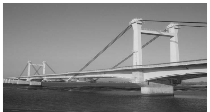
写真-3 橋梁状況
