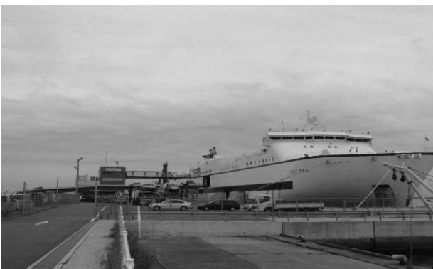
写真-1 オーシャンフェリーと完成状況
