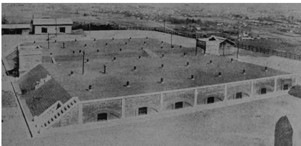
図 6 松本市城山配水池の完成後
