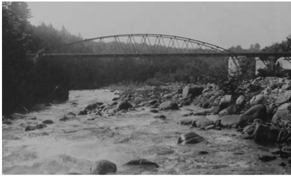
図10 河川を渡河した水管橋の事例（小布施町）
