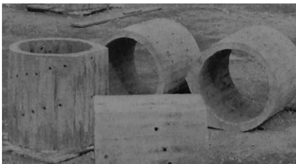
図 7 上田町 千曲川での伏流水取水の暗渠井筒
