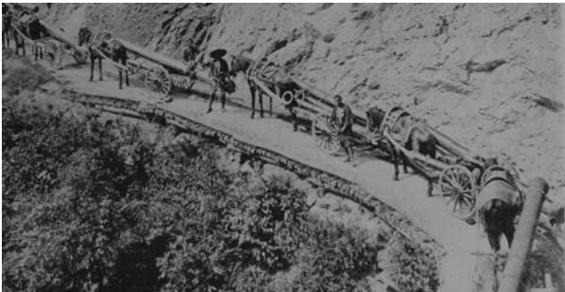
図 5 長野市創設水道で使用された鋼管の運搬
