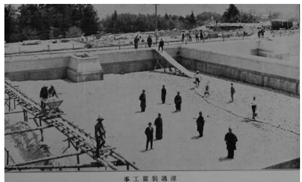
図 8 飯田町砂払浄水場 緩速ろ過池の砂投入
