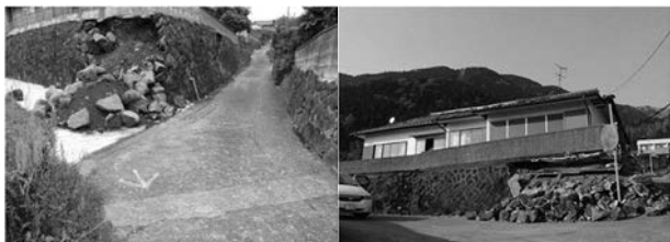
図-13 崩壊した石材が法尻に溜まっている様子
