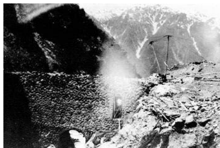
写真6 大正11年5月27日復旧工事中の1号堰堤 25)
