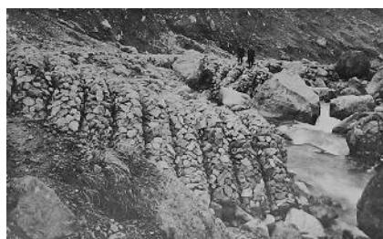
写真3 湯川左岸の制水工 16)
