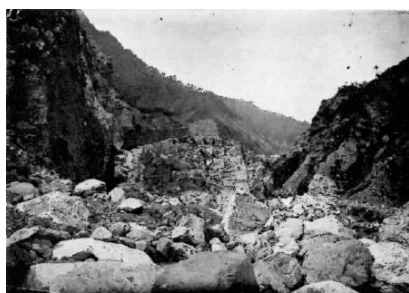
写真5 大正8年7月被災後の湯川第一号堰堤 22)
