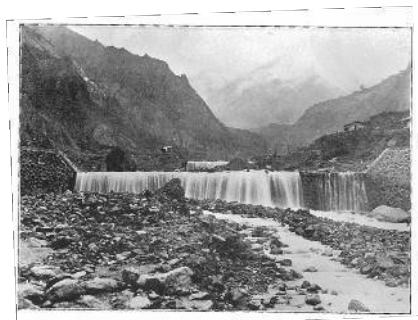
写真2 大正8年被災前の湯川の堰堤群 14)
