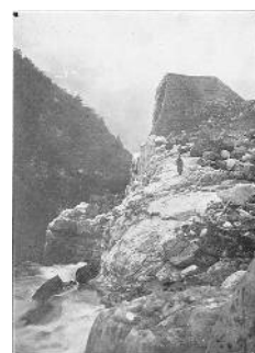
写真7 大正11年7月の被災後の写真 26)
